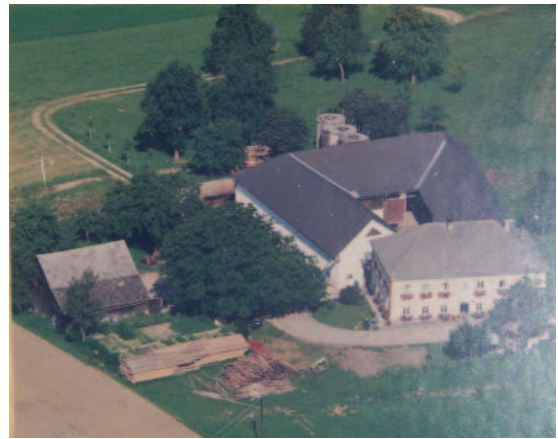
Abb.15: Hof 3 vor dem Umbau 1998
