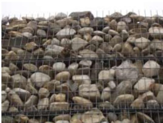
Abbildung 69: Vector Wall® Gabion
