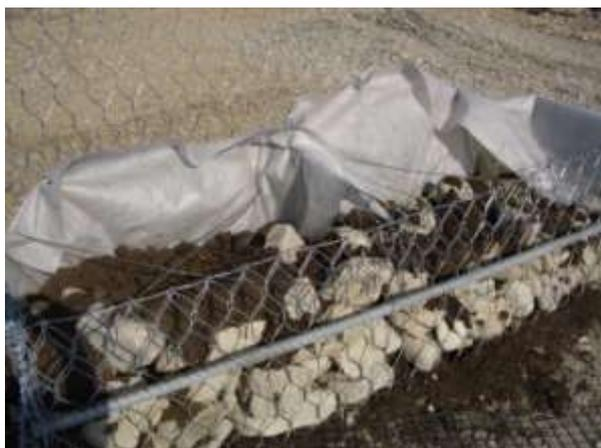
Abbildung 11: Verfüllen von Gabionen in Seebarn bei Krems Mai 2005
