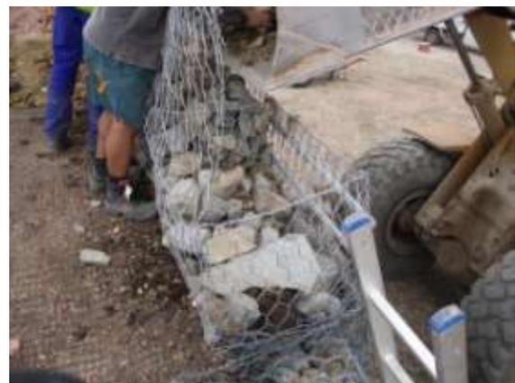
Abbildung 78: Verfüllen der Gabione Seebarn bei Krems Juli 2005
