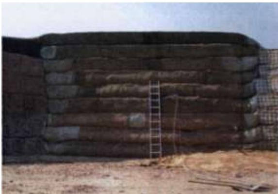
Abbildung 62: Polyslope T in Seebarn bei Krems (Quelle: FUCHS 2006)
