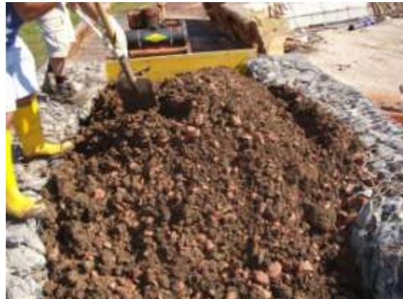
Abbildung 59: Befüllen des Hohlkerns mit Substrat 50 % Juli 2005
