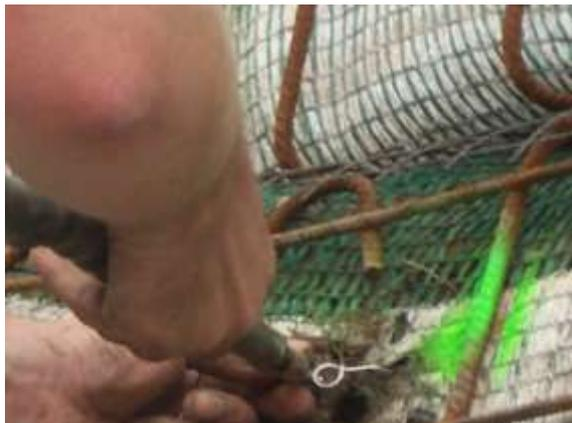
Abbildung 81: Verrödeln des Drahtes
