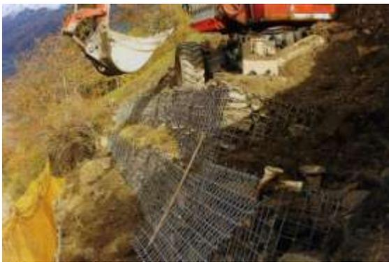
Abbildung 114: Errichtung der Gabionen
