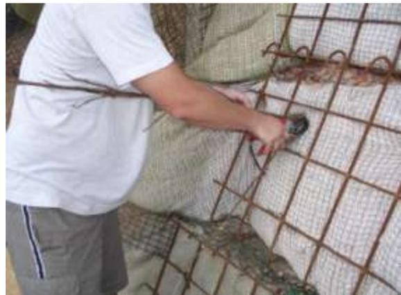
Abbildung 80: Einlegen und Zurechtschneiden der bewurzelten Pflanze Seebarn bei Krems Juli 2005
