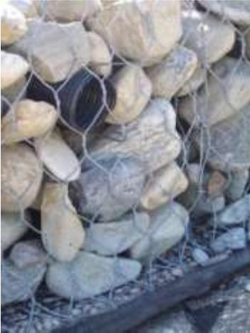
Abbildung 75: Gabione mit Drainagerohr Seebarn bei Krems Juli 2005
