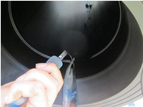
**Abbildung 37: Schweißfalz Entfernung mit Messer**
