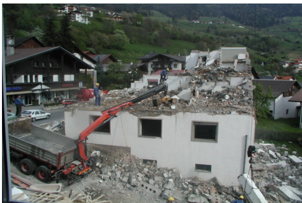
Abbildung 12: Rückbau des Gemeindeamtes Wennis/Tirol (Quelle: GEMEINDE WENNIS, 2005)
