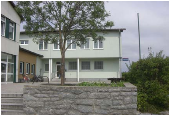
Abbildung 27: Leerstand Schulstraße 2, Gebäudeansicht von Süden (Quelle: Eigene Aufnahme am 03. 05. 2012)
