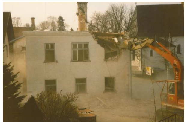
Abbildung 13: Rückbau des Volksschulgebäudes Oberhofen am Irrsee (Quelle: GEMEINDE OBERHOFEN AM IRRSEE, 1980)
