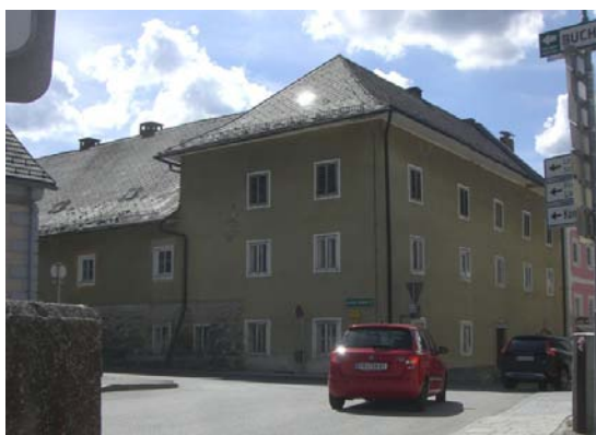
Abbildung 45: Leerstand Marktplatz 1, Gebäudeansicht von Nordost (Quelle: Eigene Aufnahme am 10. 05. 2012)
