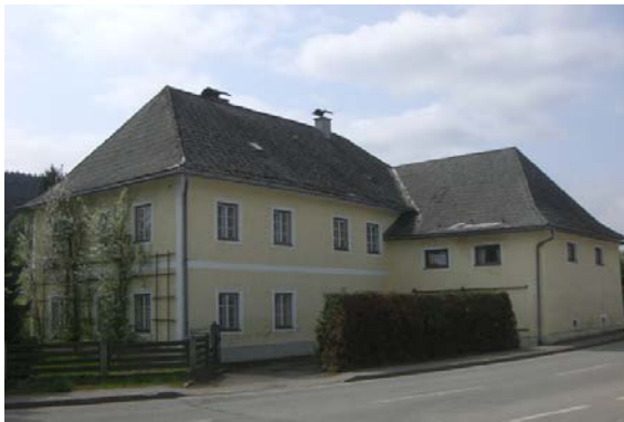
Abbildung 24: Leerstand Hafnerstraße 1, Gebäudeansicht von Nordost (Quelle: Eigene Aufnahme am 03. 05. 2012)
