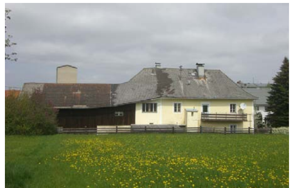
Abbildung 25: Leerstand Hafnerstraße 1, Gebäudeansicht von Süden (Quelle: Eigene Aufnahme am 03. 05. 2012)
