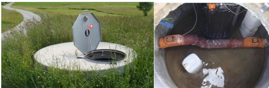
Abbildung 4-19: Dosierschacht mit Altbestand der Mischstrecke
