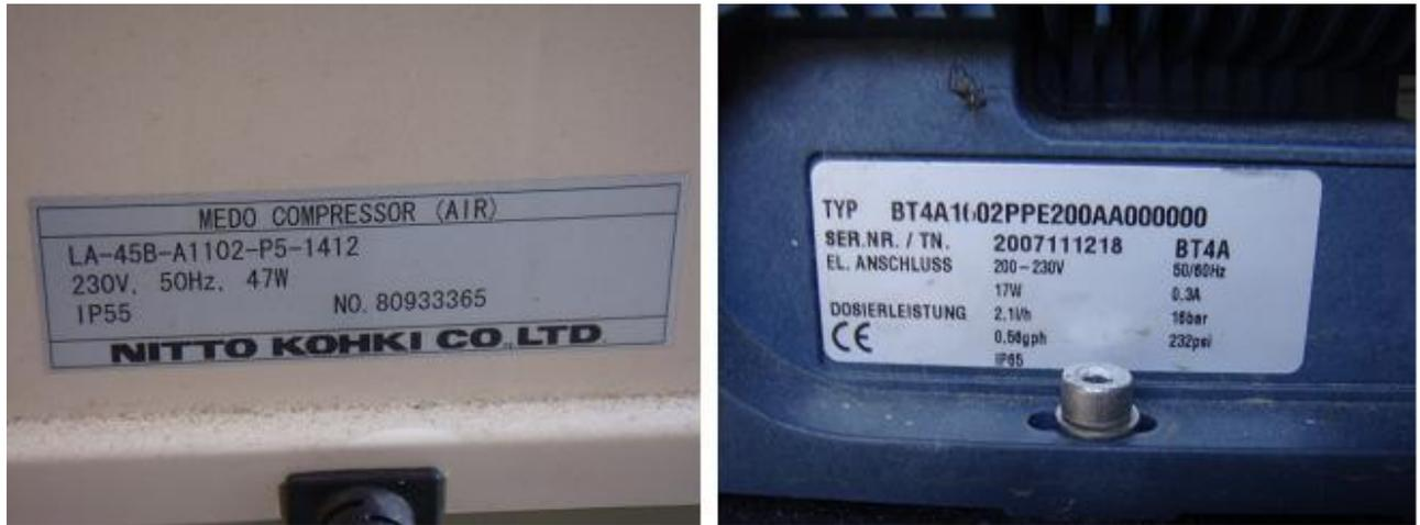
Abbildung 6-4: Typenschild Kompressor (links) und Dosierpumpe (rechts)
