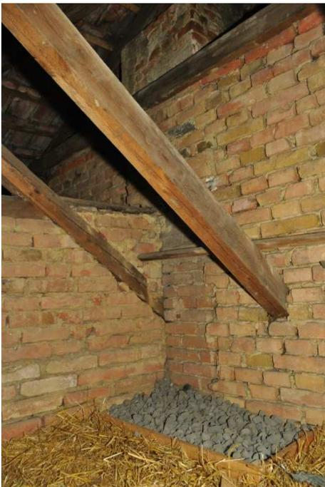
Abbildung 60: Holzkonstruktion um Kamin mit Glasschaumschotter verfüllt
