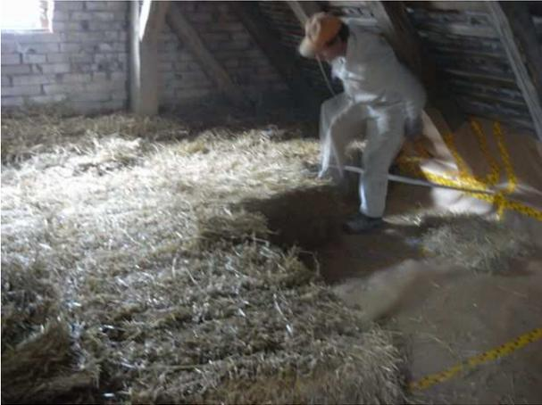
Abbildung 39: Einbringung der Strohdämmung in Mitterretzbach (aus [Breuss, 2011d])
