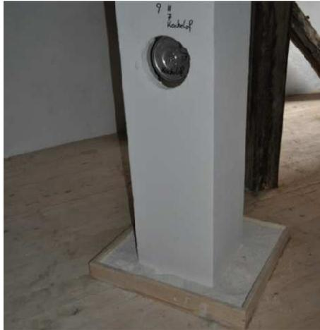
Abbildung 61: Holzkonstruktion um Kamin mit Perliten verfüllt
