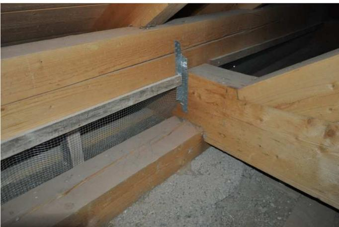
Abbildung 65: Schutzgitter zur Absicherung gegen Nager beim Einsatz von Strohdämmung
