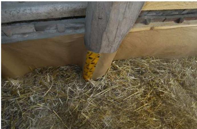
Abbildung 44: Hochgezogene Dampfbremse entlang der Dachhaut in Mitterretzbach (aus [Breuss, 2011d])
