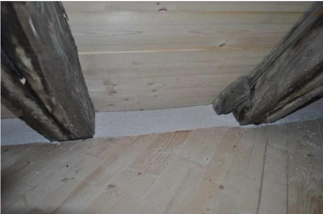
Abbildung 62: Anschluss OGD - Dach mit Perliten verfüllt
