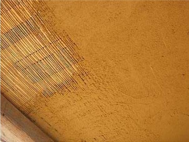
Abbildung 20: Lehmputzschicht der Decke zu unbeheiztem Dachraum in Ravelsbach (aus [Gruber, 2008])
