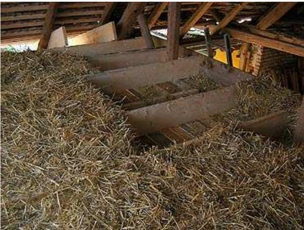
Abbildung 21: Dämmung der OGD 1 in Ravelsbach (aus [Gruber, 2008])
