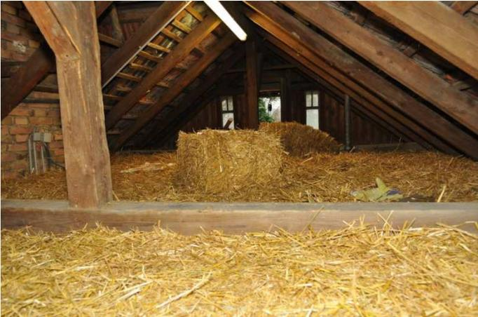
Abbildung 64: Dachbodenansicht nach Einbringung einer Strohdämmung
