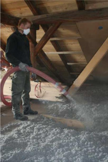
Abbildung 67: Einblasung von Zellulose in die oberste Geschoßdecke (aus [Bilderarchiv GrAT, 2011])
