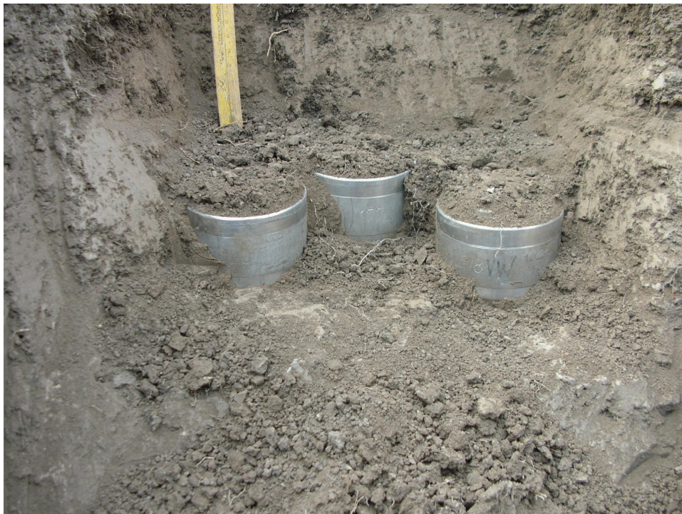
Abb. 19: Die Erde um die Zylinder wird entfernt (Foto: STREBL, 2006)
