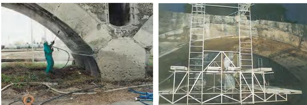
(a) Arbeiten mit dem Hochdruckwasserstrahl an der Floridsdorfer Hochbahn (b) Spritzbetonarbeiten an der Floridsdorfer Hochbahn
