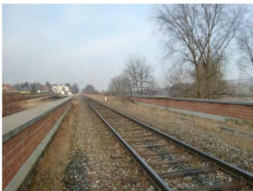
(a) Ansicht der exzentrischen Lage der Eisenbahnschienen
